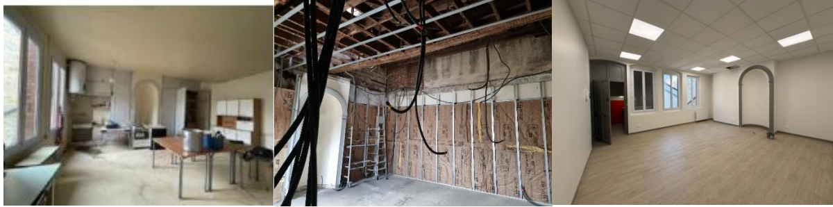
Cuisine (avant travaux/pendant travaux/aujourd'hui)
