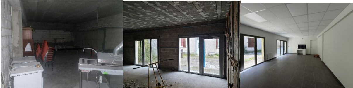
Garage (avant travaux/pendant travaux/aujourd'hui)
